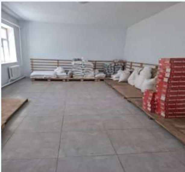
Проведено ремонт 40 кв.м. підлоги в складі сухих продуктів
