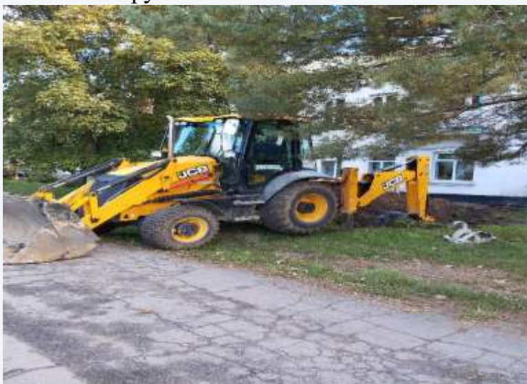
Проведено поточний ремонт водогону до І-го житлового корпусу
