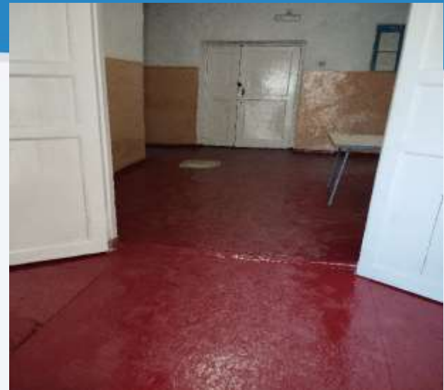
Проведено поточний ремонт підлоги в коморі
