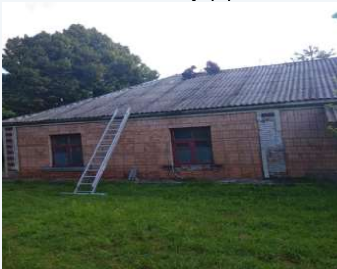
Проведено поточний ремонт даху майстерні
