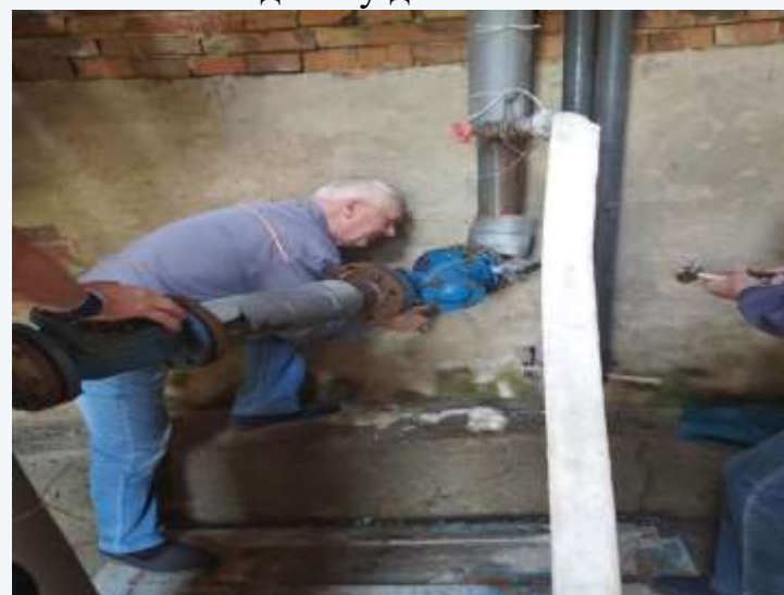
Проведено поточний ремонт водонапірної вежі
