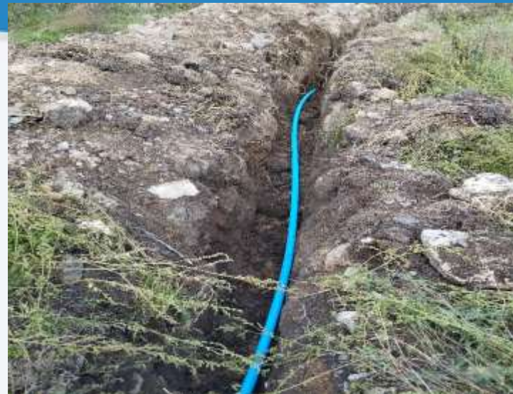
Проведено поточний ремонт 60 м водогону до котельні
