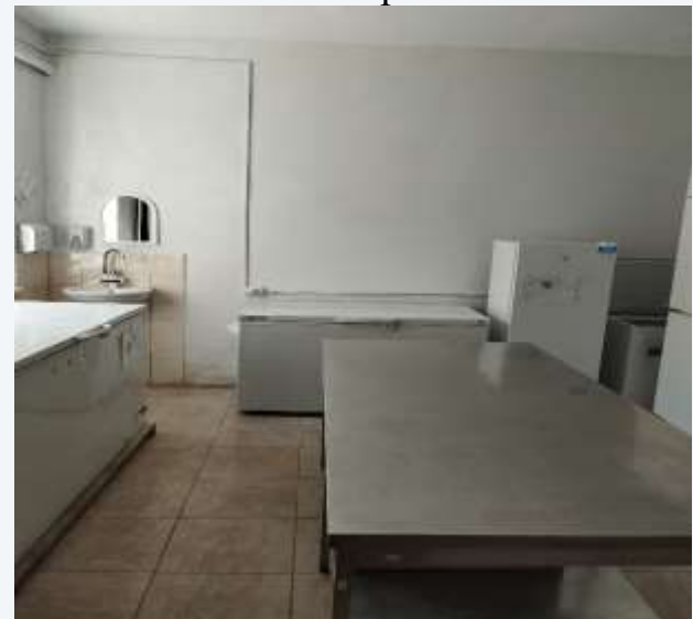
Проведено поточний ремонт холодильної кімнати комори
