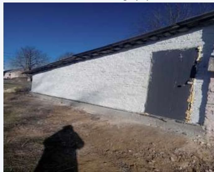
Проведено поточний ремонт стін овочесховища
