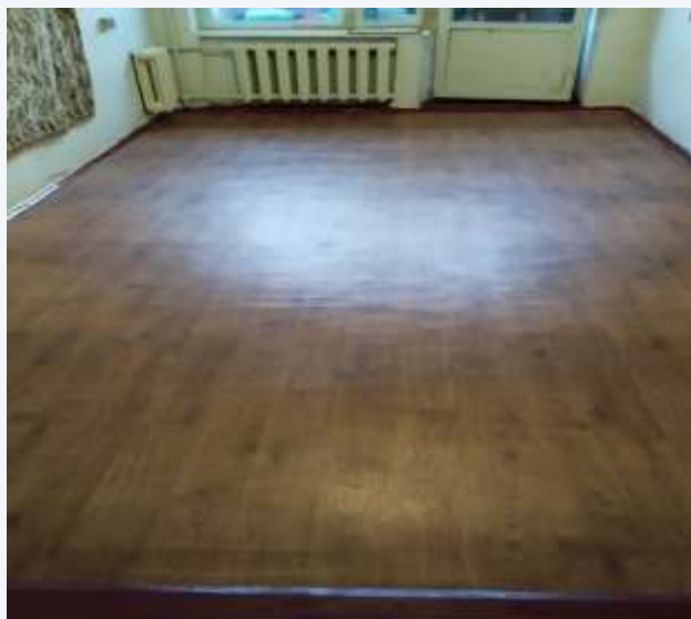
Замінено 420 кв.м. лінолеуму в 19 житлових кімнатах закладу
