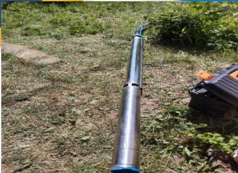
Проведено заміну глибинного насоса та труби глибиною 80 м.
