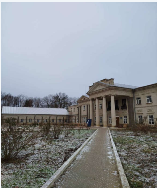
Поточний ремонт покрівлі головного корпусу 1772,6 тис.грн.
