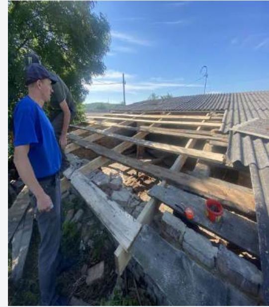
Відремонтовано дах овочесховища
