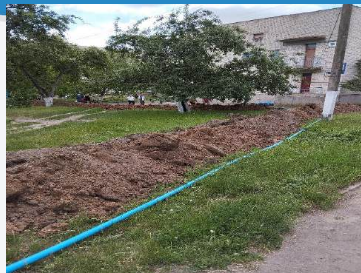
Проведено поточний ремонт 146 п/м водогону II-III корпусів
