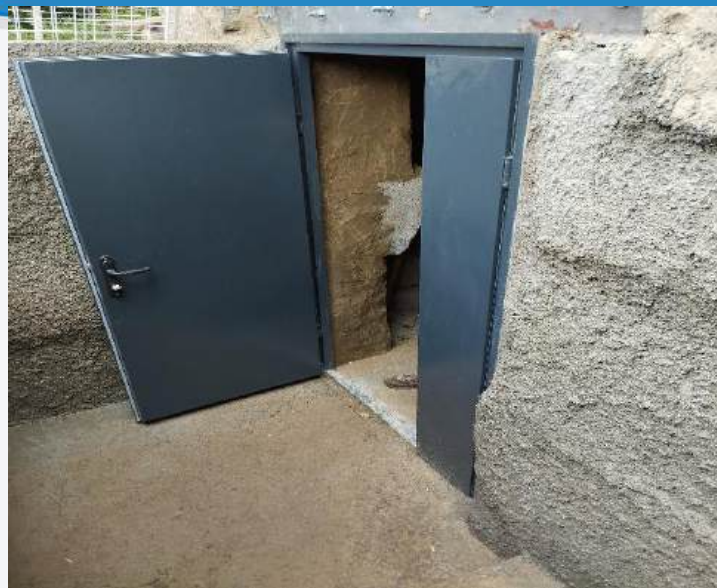
Облаштовано 2 аварійний вихід укриття №3
