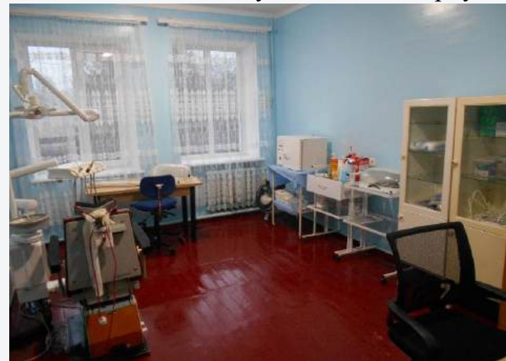
Проведено поточний ремонт в кабінеті стоматолога
