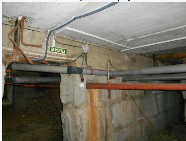
Проведено поточний ремонт 70 п/м каналізаційної системи III корпусу
