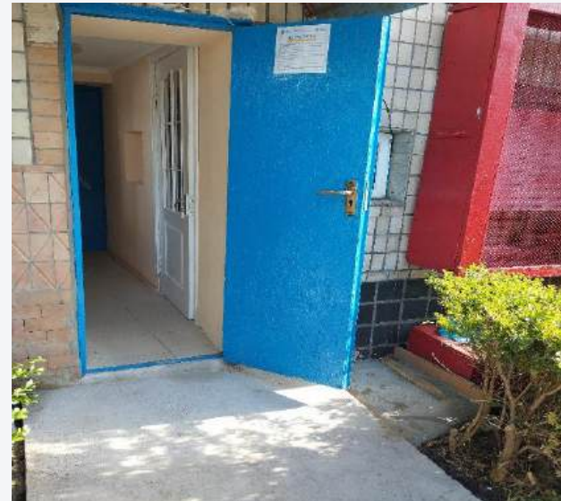
Проведено поточний ремонт прохідної закладу
