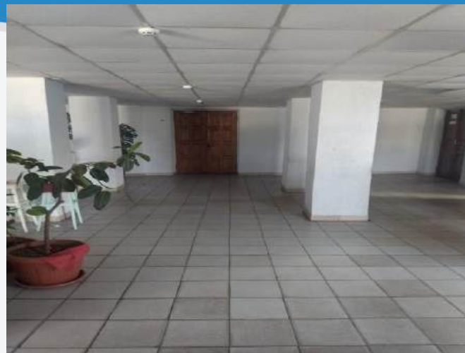
Проведено поточний ремонт фойє I корпусу
