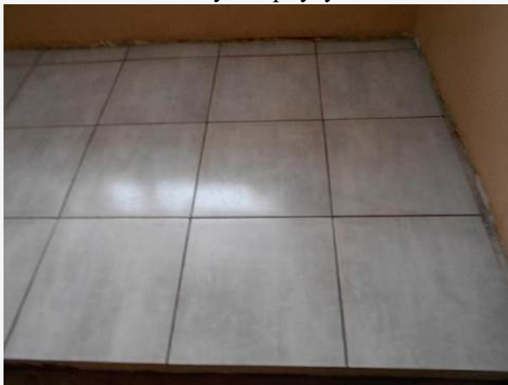
Проведено поточний ремонт сходових площадок III корпусу
