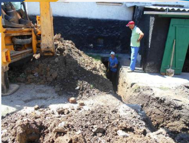
Проведено поточний ремонт 127 п/м водогону I корпусу
