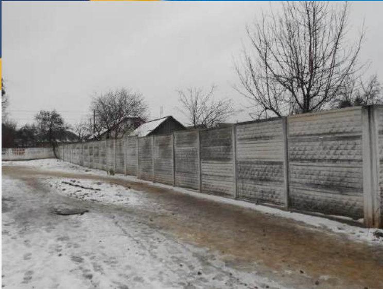
Проведено поточний ремонт огорожі закладу 50 п/м
