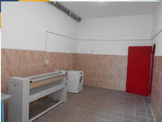
Проведено ремонт гладильної кімнати пральні
