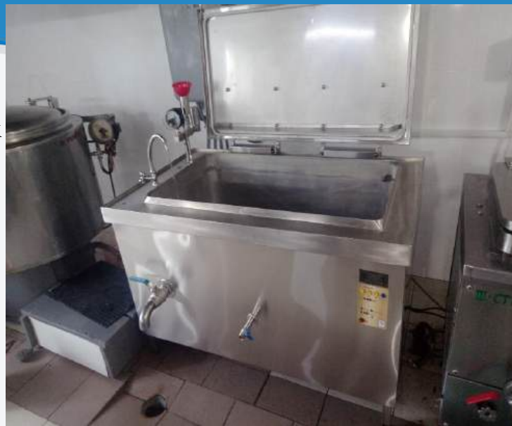
Встановлено котел на 250 л. в харчоблоці
