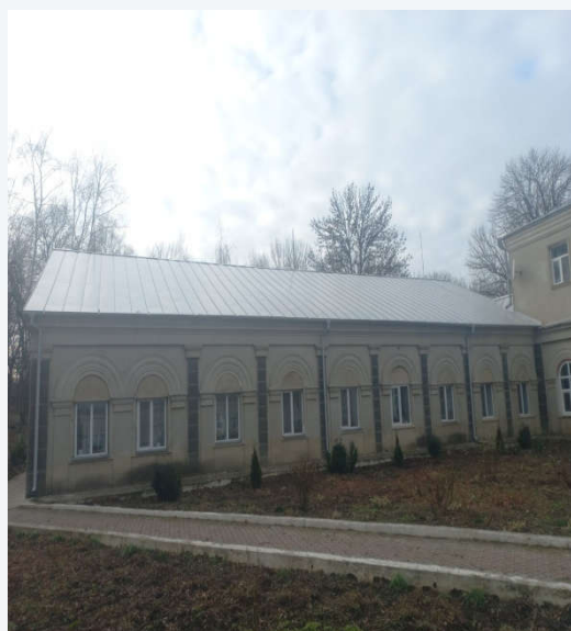
Поточний ремонт покрівлі правого флігеля 1121,6 тис.грн.
