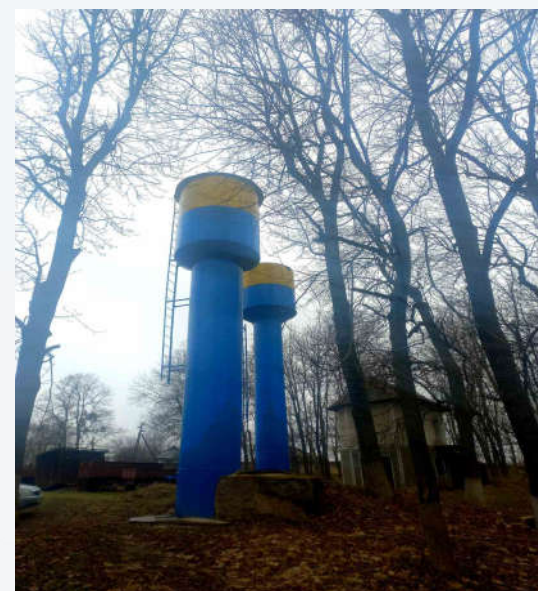
Поточний ремонт зовнішніх мереж водопостачання 81,7 тис.грн.
