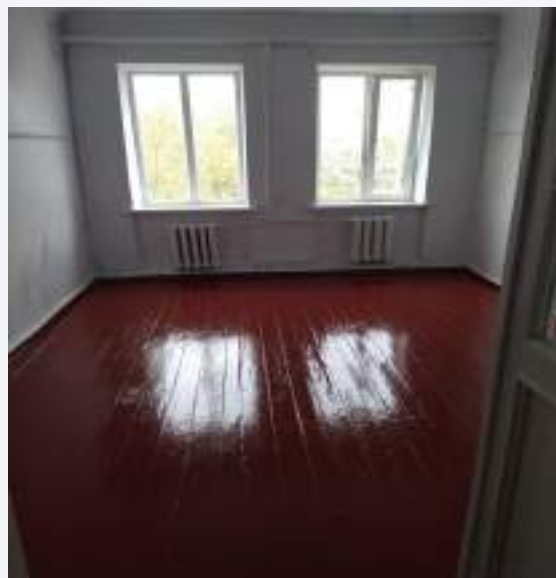
Проведено ремонт 116 житлових кімнат
