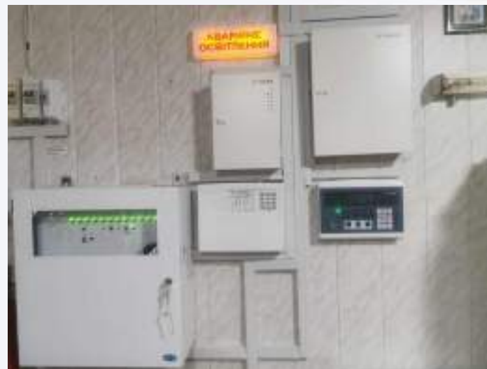
Встановлення протипожежної сигналізації
