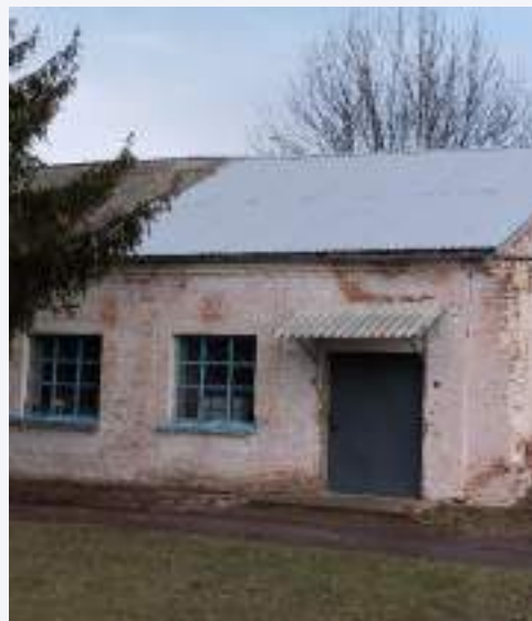
Ремонт даху комори
