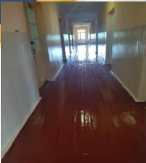
Проведено ремонт коридору 1 житлового корпусу
