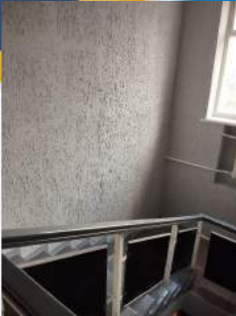
Проведено ремонт коридору адмінкорпусу
