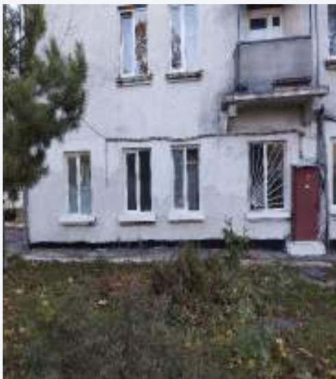
Проведено ремонт фасаду 1 житлового корпусу – 250 КВ.М.
