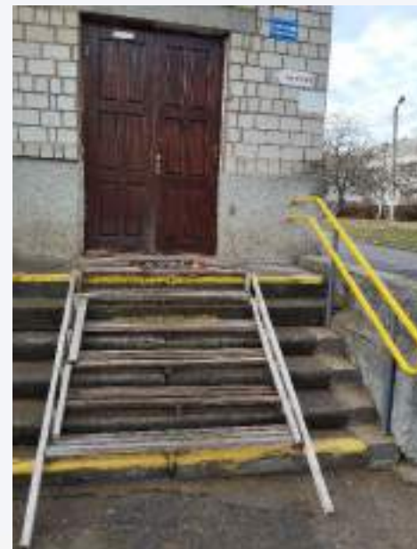
Встановлено поручні сходів 2 житлового корпусу
