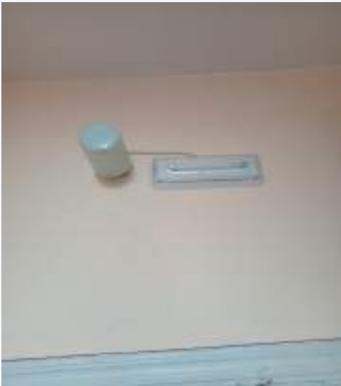
Встановлено 60 ламп аварійного освітлення
