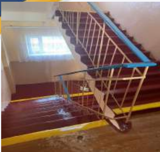
Проведено ремонт сходових клітин житлових корпусів
