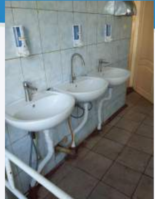
Замінено умивальники в 1 корпусі
