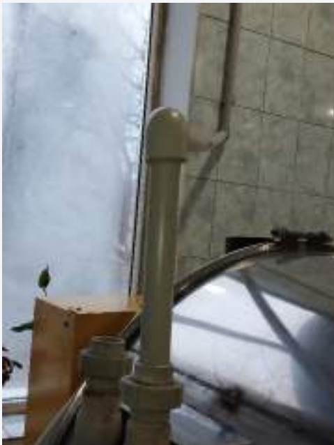
Відремонтовано водогін в пральні
