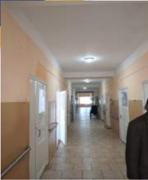
Замінено 35 шт. світильників в корпусах
