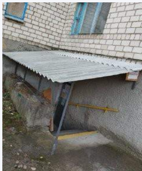
Облаштовано накриття входу в укриття 2 житлового корпусу
