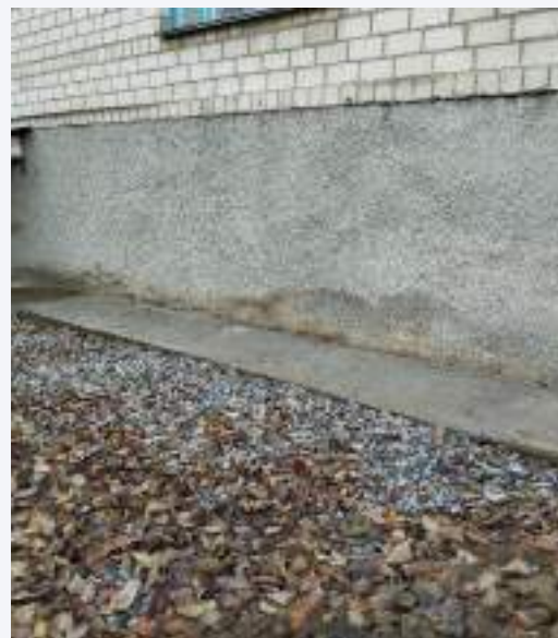
Облаштування відмостки 2-3 житлових корпусів
