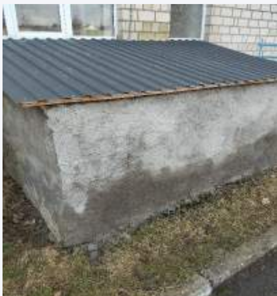
Облаштовано накриття входу в підвал 3 житлового корпусу
