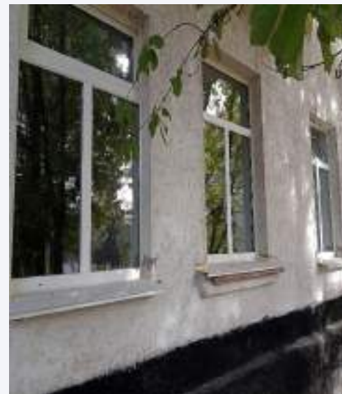
Замінено 25 вікон 1 житлового корпусу
