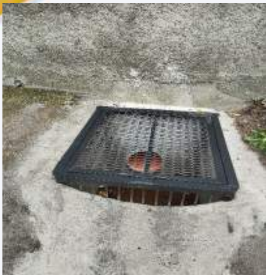
Ремонт дренажної системи під галереєю
