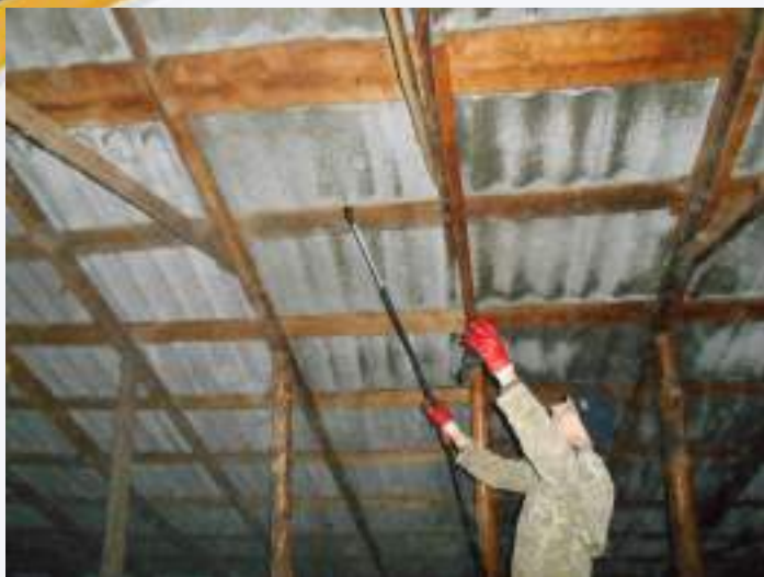
Обробка дерев'яних конструкцій даху майстерні та 3 житлового корпусу
