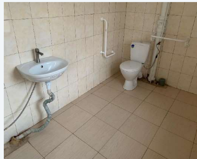
Проведено ремонт кімнати гігієни 3 корпусу
