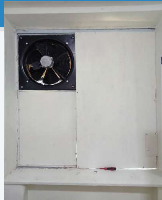
Облаштовано вентиляцію в холодильній кімнаті
