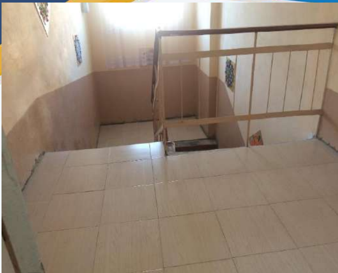
Проведено ремонт сходових площадок 2 корпусу
